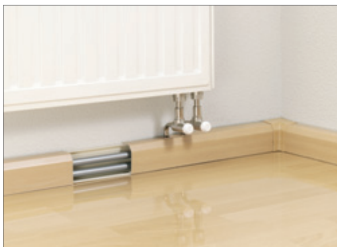
Рис. 4-14 Подключение к радиатору из плинтуса
