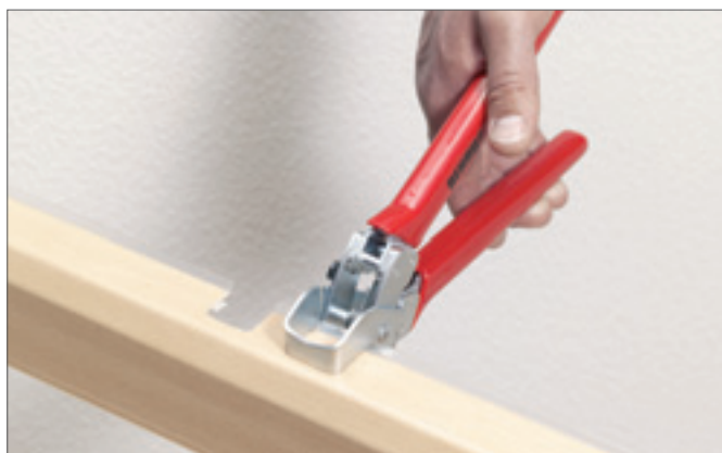
Рис. 18-40 Вырезка прямоугольных отверстий в крышке плинтусных каналов
