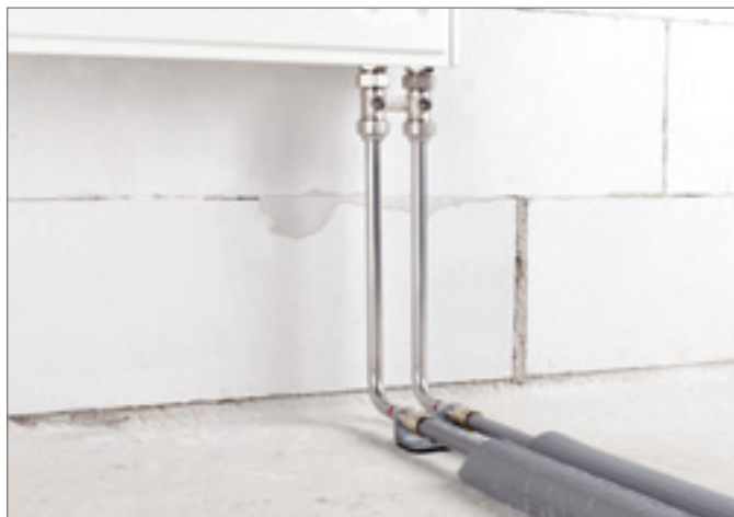
Рис. 4-12 Подключение к радиатору из пола
