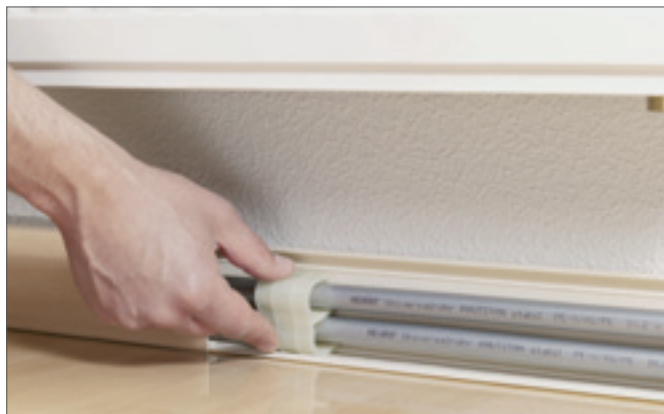
Рис. 18-37 Установка фиксаторов труб отопительной разводки
