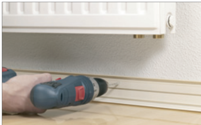
Рис. 18-31 Закрепление основания плинтусного канала RAUSOLO
