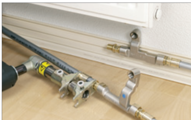
Рис. 18-34 Соединение с помощью подвижной гильзы, трубы \varnothing 16 с крестовиной SL-RAUTITAN из комплекта
