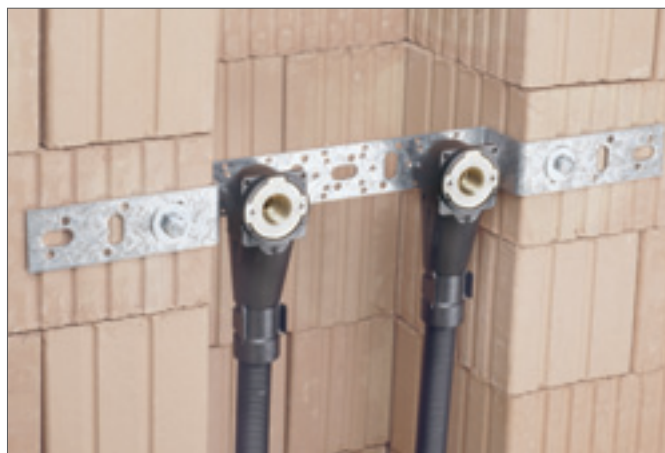
Рис. 6-5 Пример монтажа кронштейна 75/150 для подключения в шахте
