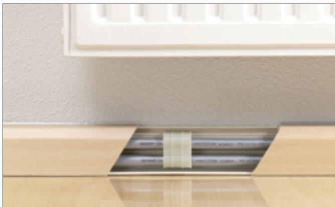
Рис. 18-24 Фиксация труб отопительной системы в плинтусном канале RAUSOLO
