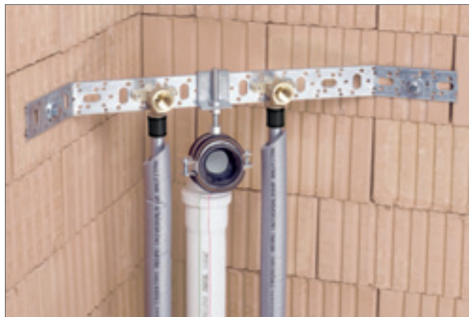
Рис. 6-4 Пример монтажа кронштейна
