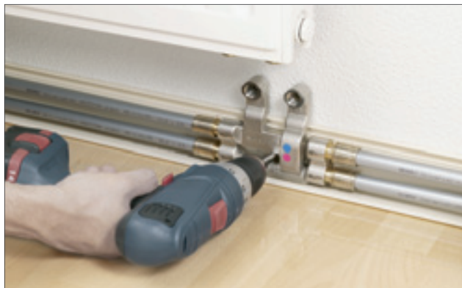
Рис. 18-36 Закрепление крестовины SL-RAUTITAN
