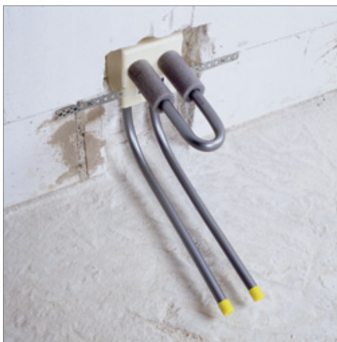
Рис. 4-13 Подключение к радиатору из стены
