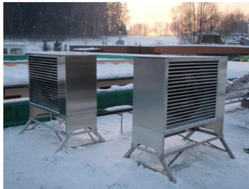
Сплит система, установленная на крыше
