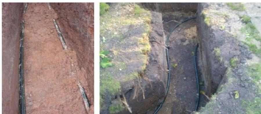
**Пример укладки труб при параллельной инсталляции**
