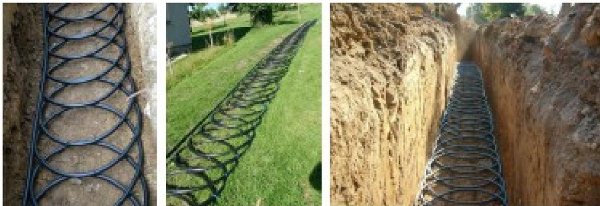
**Пример укладки труб при спиральной инсталляции**
