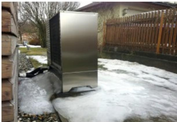
Пример замерзания неконтролируемого оттока конденсата (риск получения травм на образовавшейся ледовой корке)
