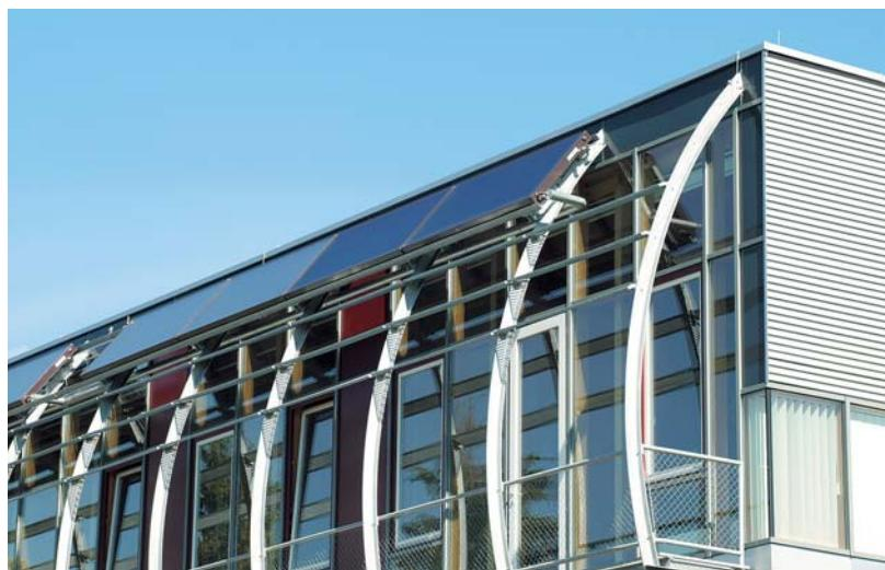
Рис. B.1.7-2 Использование коллекторов для затенения
