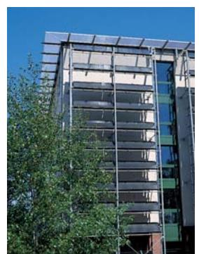
Рис. В.1.6-17 Монтаж на стене (наклонная поверхность)
