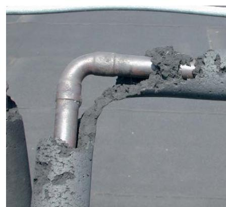
Рис. В.3.2-5 Повреждение мелкими животными.
