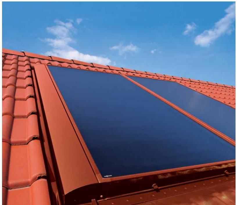
Рис. В.1.7-3 Коллектор как подобранный по цвету элемент крыши.
