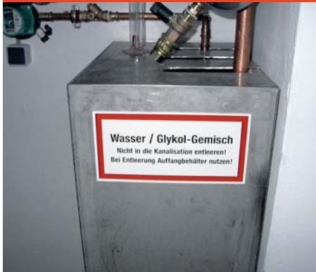
В больших солнечных системах применяются приемные емкости из нержавеющей стали с крышкой, на которую рекомендуется наносить маркировку.
