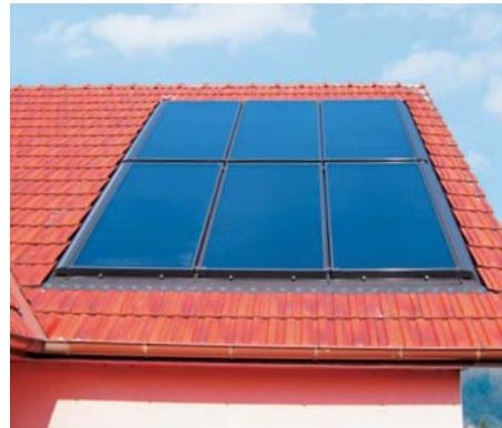
Рис. В.1.6-8 Встраивание в кровлю
