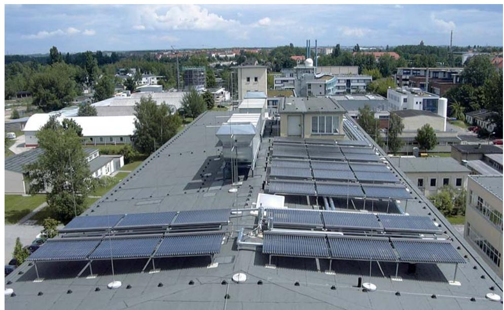
Требуемые температуры, в зависимости от производителя и области применения абсорбционной холодильной машины, составляют около 90 °C, то есть несколько выше, чем температура теплоносителя в солнечном коллекторе. Поэтому только вакуумированные трубчатые коллекторы пригодны для использования – с плоскими коллекторами требуемых температур можно достичь только с очень низким коэффициентом полезного действия.
