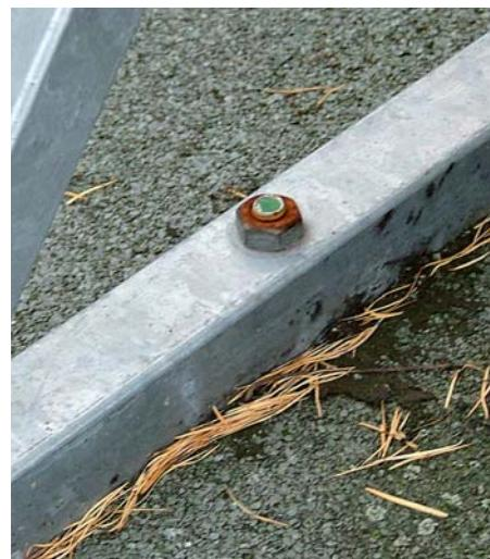
Рис. В.1.6-18 При выборе материалов следует помнить, что коррозия абсолютно недопустима.
