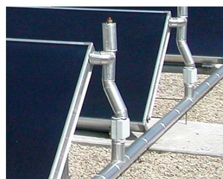
Рис. В.3.2-6 Защита от мелких животных и ультрафиолетового излучения.
