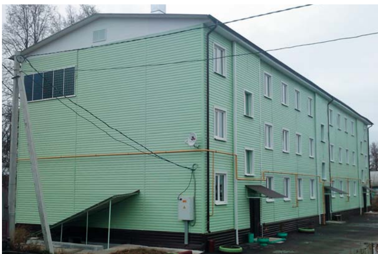
Дом в г. Кондрово с теплонасосным отоплением
